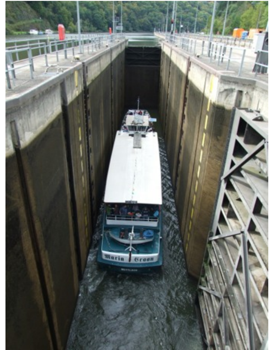
Ecluse de Mettlach
